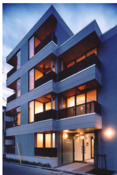
図 9 無梁板壁式構造による集合住宅
