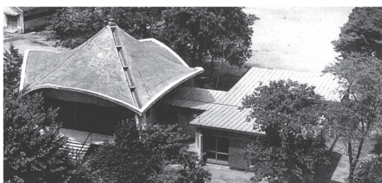
図9 「長覚院」本堂のHPシェル屋根(左棟)
