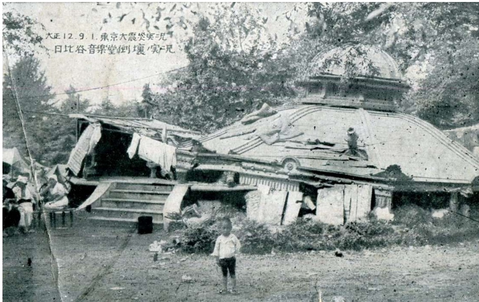
図6 「日比谷音楽堂倒壊」(「震災絵はがき」より)(1923年)
