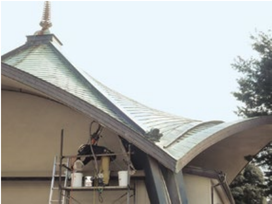
HP シェルを4枚組み合わせた形状の長覚院の屋根(左)。図面も残されている。
